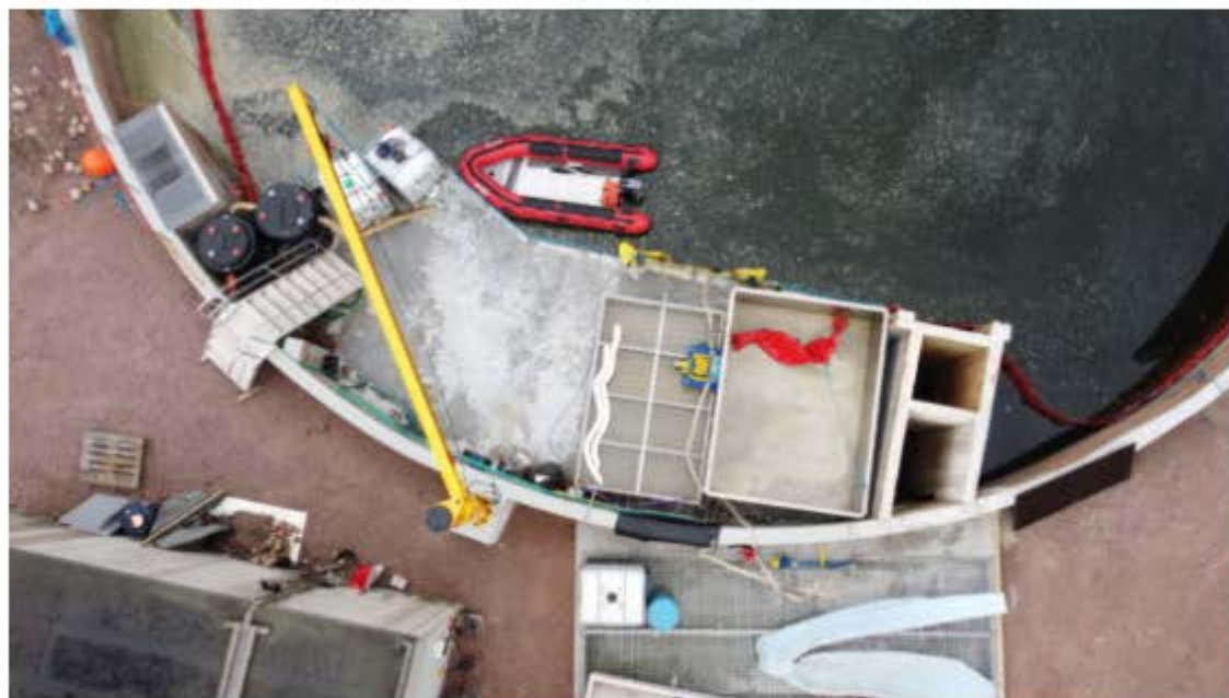
Kuva 4. Työskentelytasolla testiallas, ritilöity pesuallas ja öljynerotuslaitteisto, altaan ulkopuolella kiinteä valuma-allas ja kääntöpuominosturi. Kesällä 2021 maaperää ei vielä oltu asfaltoitu. (kuva Manu Kettunen).
