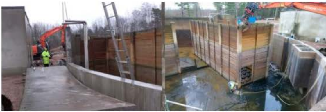
Kuva 2. Rakenteiden purkua (kuvat: Antero Myrén ja Justiina Halonen).
