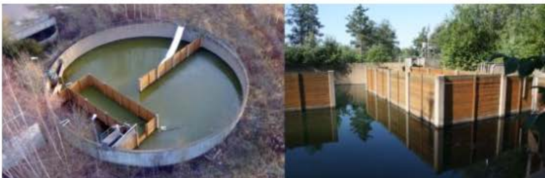
Kuva 1. Altaan muutostöiden lähtötilanne (kuvat: Harri Sane ja Justiina Halonen).
