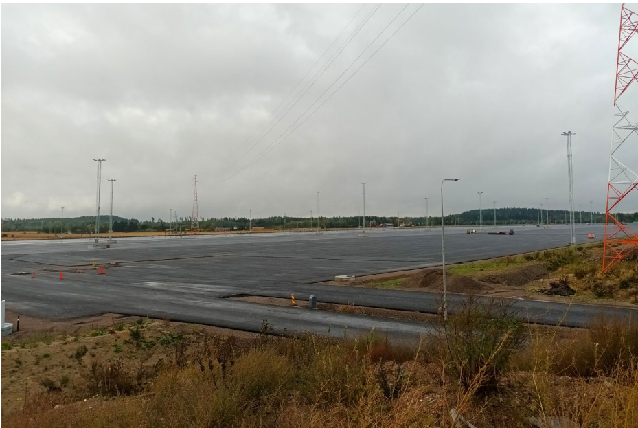
Kuva 2. Kouvolan RRT-alue otetaan käyttöön vuonna 2023. Syksyllä 2022 otetussa kuvassa asfaltoitu kenttä, valaistus ja lastausraide alkavat olla valmiina. (Kuva: Tiina Poikolainen)
