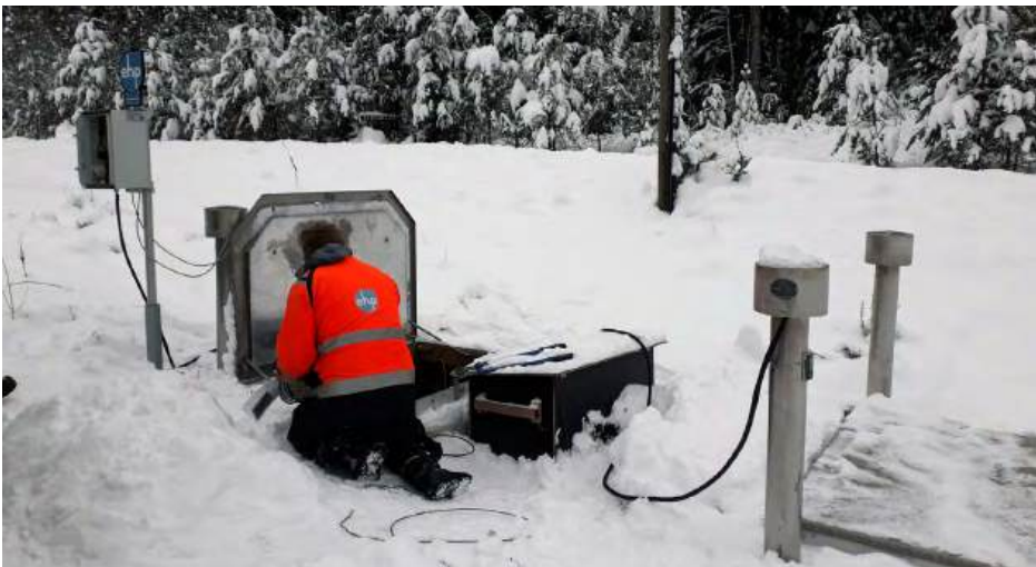
KUVA 3. EHP Environment Oy asensi Ponselin anturit pumppaamoon tammikuussa 2021 (kuva Riina Tuominen).
