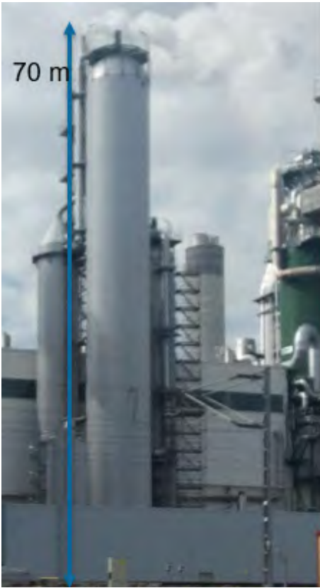
KUVA 1. Erään biotuotetehtaan happidelignifiointivaihe (kuva Jari Käyhkö).
