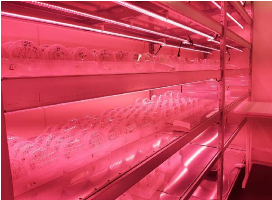
KUVA 2. KasvuI-toimitilan idätys huoneissa on led-valot ja säädettävät olosuhteet (kuva Luonnonvarakeskus).
