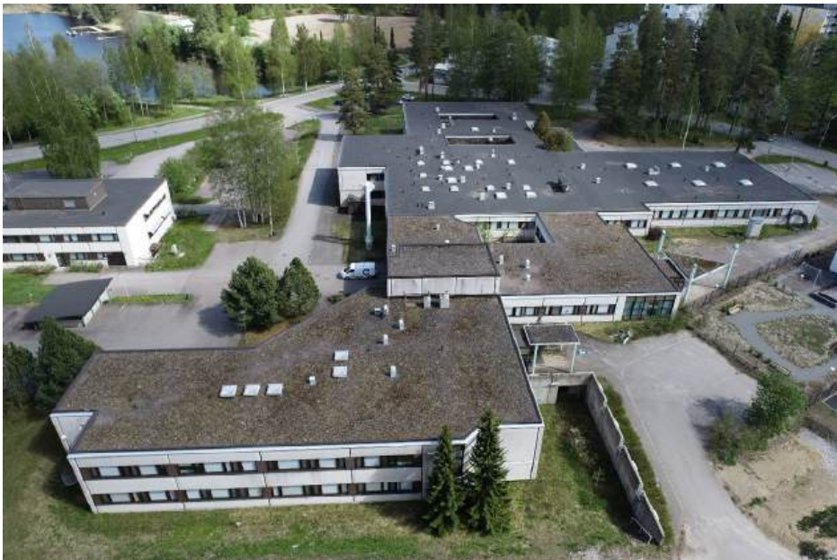
KUVA 2. Droonikuvausta hyödynnetään purettavien rakennusten materiaalivirtojen seurannassa (kuva Esa Hannus).
