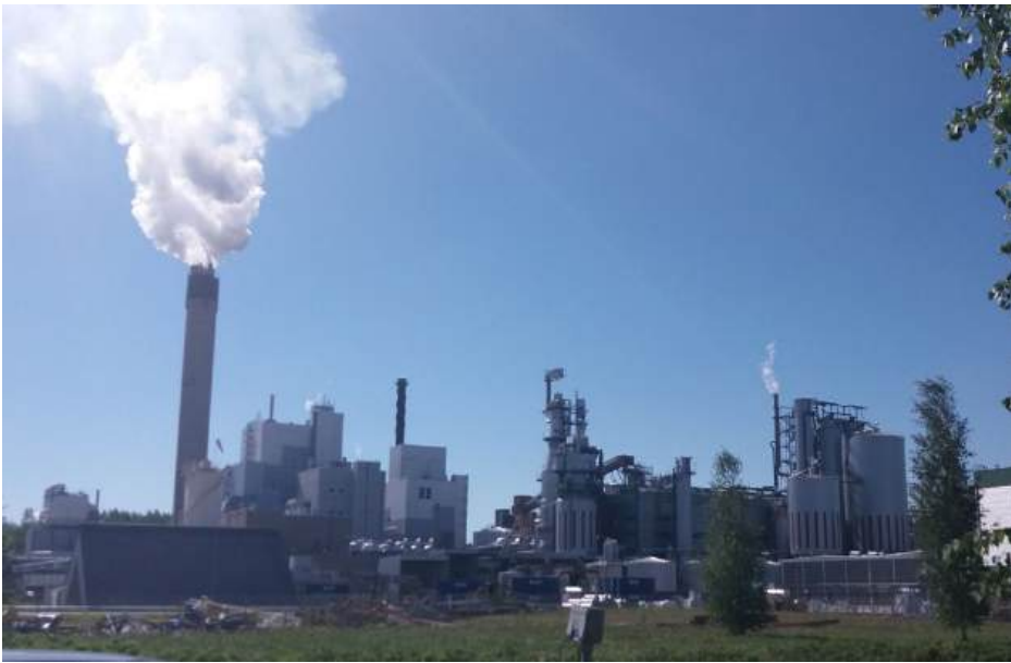
KUVA 1. Kaukopään sellutehdas (kuva Jari Käyhkö).
