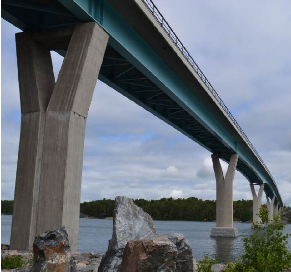
KUVA 2. Lövön sillan teräsbetoniset pilarit (kuva Päivi Eskola, 2019).
