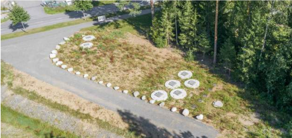
KUVA 1. Pitkäjärven hulevesijärjestelmä. Keskellä näkyvät viisi vierekkäistä kaivoa sisältävät suodatinmateriaalit. (kuva Juha Vihavainen)
