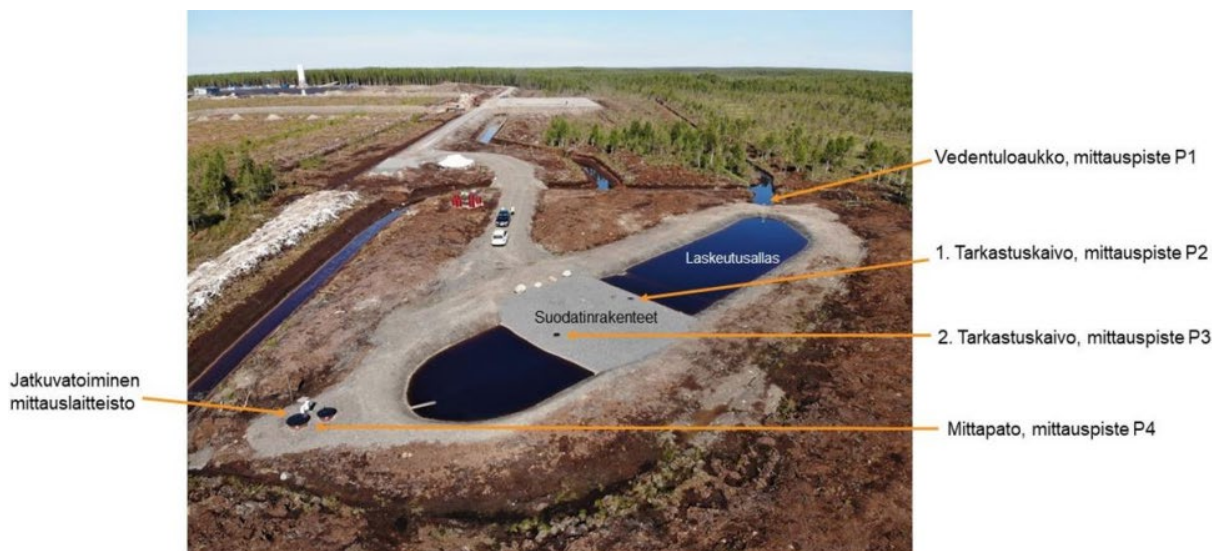
Kuva 16. Välimaan kiertotalousalueen hulevesirakenne (Sirviö ym. 2020).
