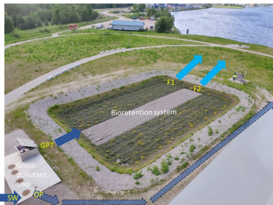
Kuva 25. Hulevesien käsittelyjärjestelmä: SW = valtatie hulevedet (GPT sisääntulo), GPT = karkeasuodattimen ulosvirtaus, F1 = kasvillisuudella varustetun biosuodatusalueen ulosvirtaus, F2 = hiukkasuodatuksen ulosvirtaus, OP = ylivuotokuoppa (Lange ym. 2021b).
